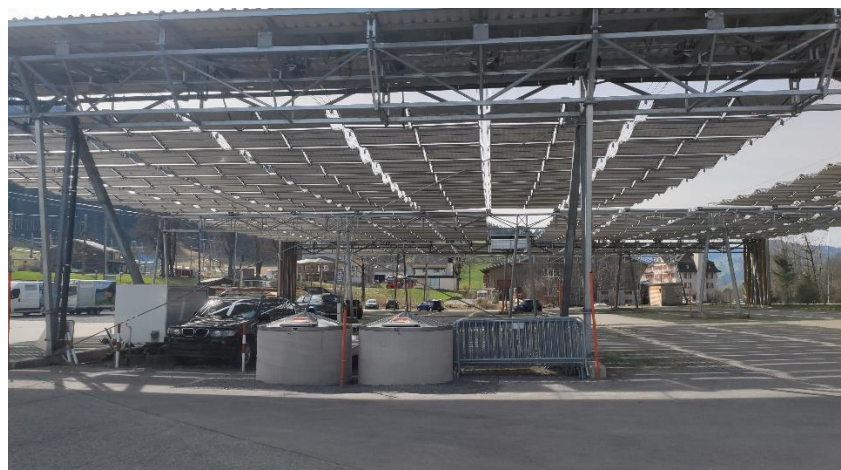
Quelle: Fotos Hersche Ingenieure AG (20.03.2024).
