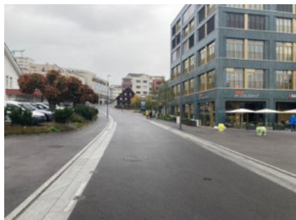
Abb. 46 Referenz doppelte seitliche Bandierung (80 cm), Lindenstrasse Uzwil (Eigene Aufnahme)
